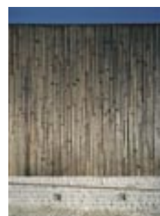
Ulkokehän ikkunaseinän liimapuiset pystyriivat. Umpiosat vaakaelementtejä.
