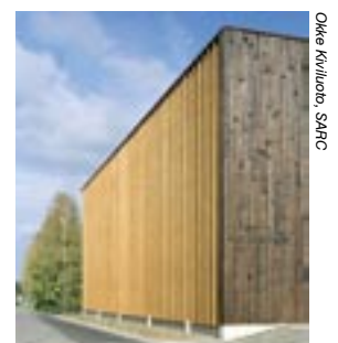
Ulkokehän ikkunaseinän liimapuiset pystyriivat. Umpiosat vaakaelementtejä.
