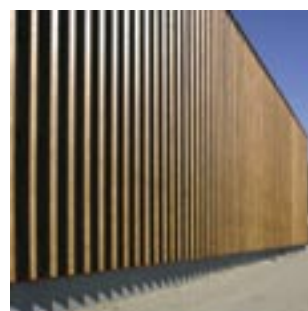
Ulkokehän ikkunaseinän liimapuiset pystyriivat. Umpiosat vaakaelementtejä.
