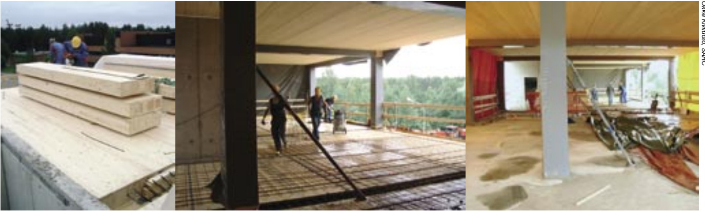
Puisten kotelolaattojen päälle valettiin betoni, joka sitoo laataston jäykäksi levyksi.
