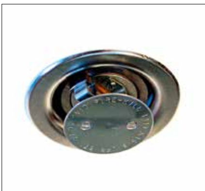
Kuva 64. Matalapainesumusuutin asennettuna. Kuva: Enexia
