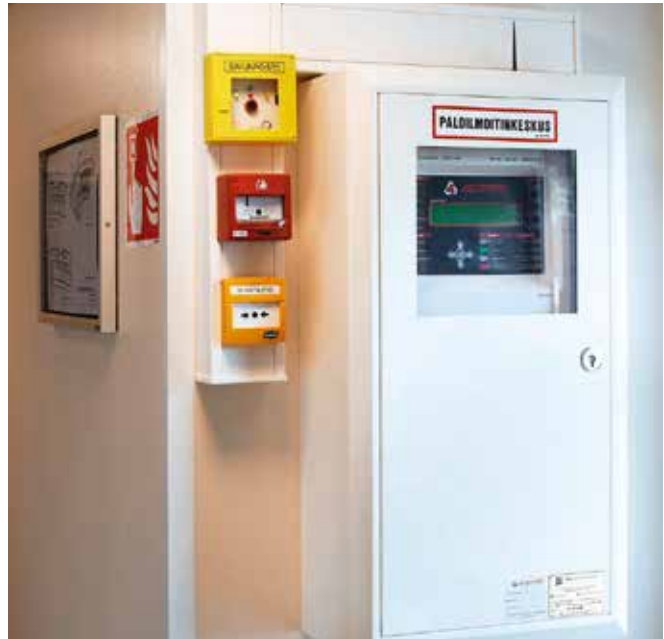
Kuva 59. Asuinkerrostalon paloilmointikeskus.
