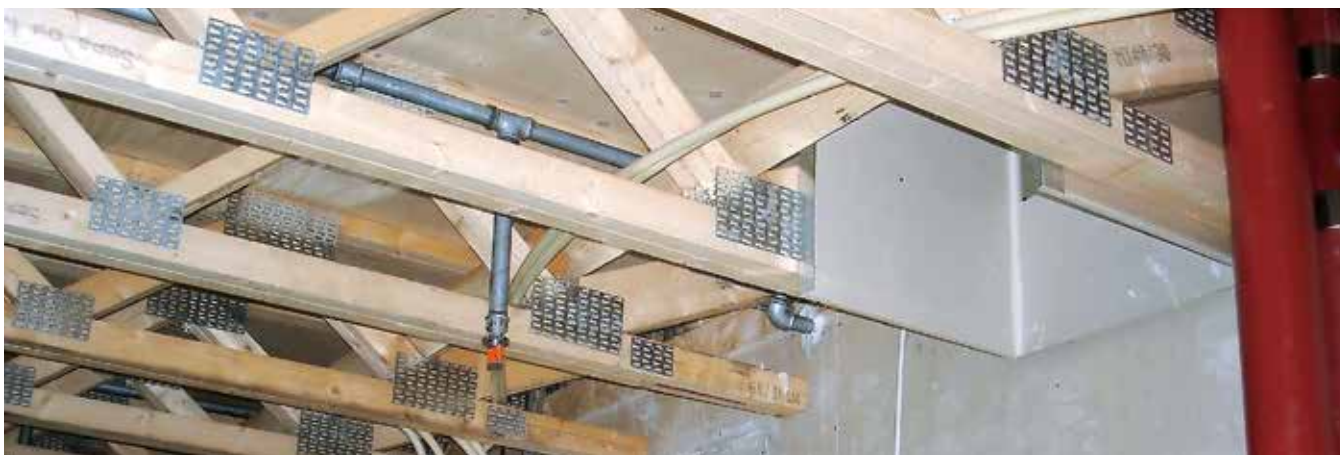
Kuva 63. Perinteinen sprinkleriputkisto asennettuna asuinkerrosten välipohjaan.
