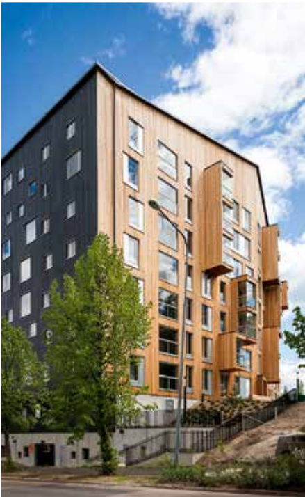
Kuva 9. Puurunkoinen asuinkerrostalo, jossa on kahdeksan kerrosta ja pääasiallisesti maan alla oleva kellarit.
