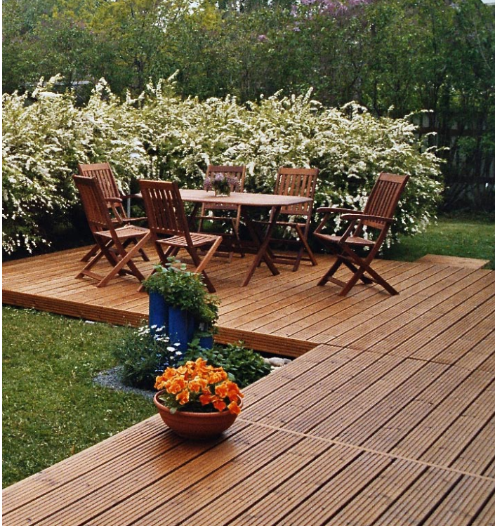
Terassi lämpökäsiteltyä kuusta, jonka pinnalla kuultokäsittely
