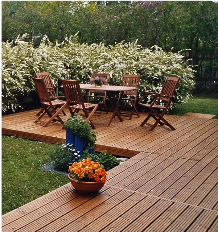
Terassi lämpökäsiteltyä kuusta, jonka pinnalla kuultokäsittely
