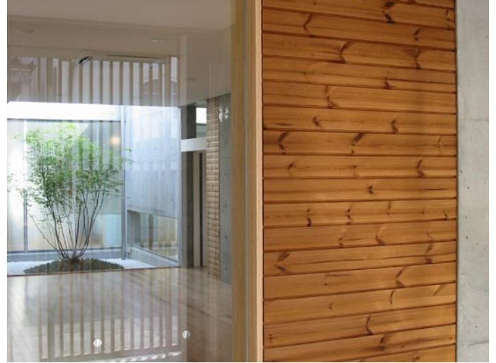
Seinä lämpökäsiteltyä mäntyä
